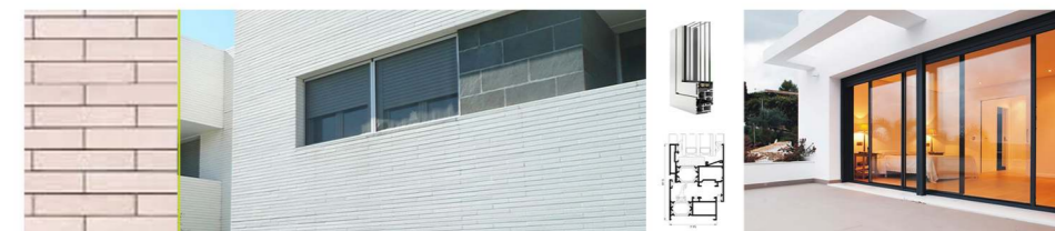
Fachada y carpintería exterior
